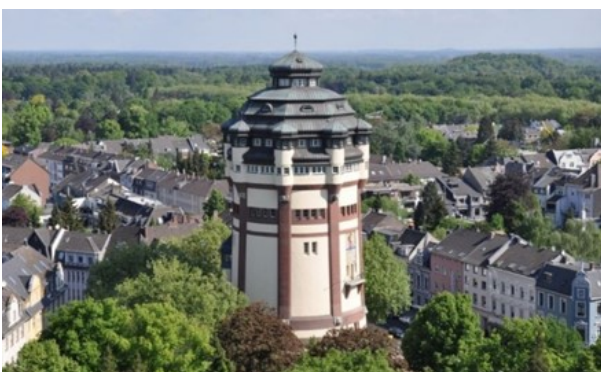
Otto Greiß, Neuer Wasserturm, 1907-09, Mönchengladbach-Windberg
